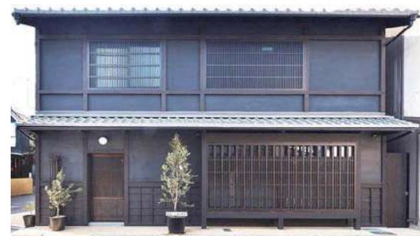
新築京町家「エル・ラガール」(外観)
