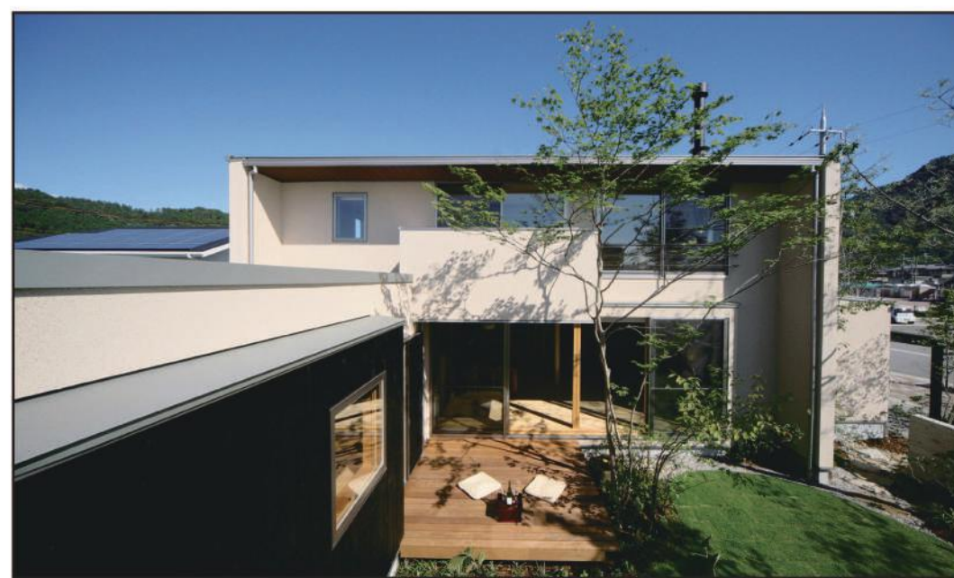
KOTOS 由良工務店のモデルハウス（外観）
