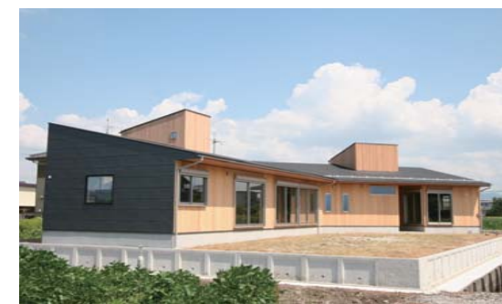
『平屋のクノジハウス』(外観)
