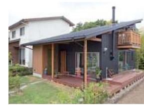
Bin0里山モデルハウス（外観）
